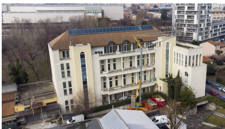
L'ampia struttura di circa 3 mila metri che diventa il quartier generale di Piazza dei Mestieri Milano
