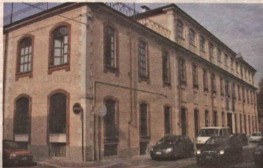
L'edificio di via Jacopo Durandi dove sorge la Piazza dei mestieri
